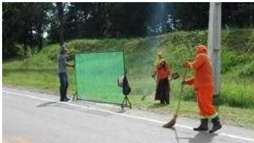
Figura 88. Exemplo de protetor de roçagem (painel de rede ou tela)
