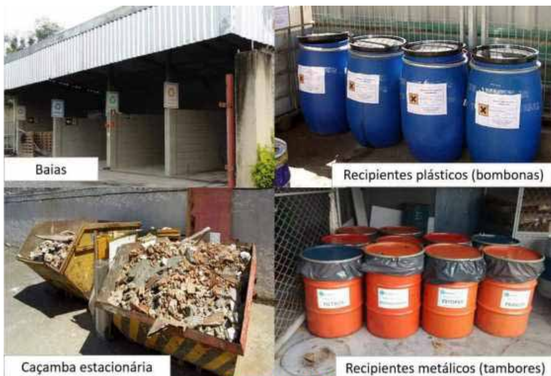
Figura 90. Formas de acondicionamento temporário para resíduos de construção civil
